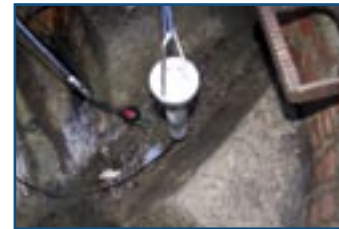
MODUL autark Einsatz im Abwasserkanal
